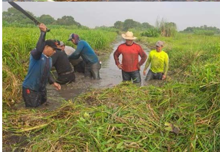
Limpeza de canales para mejorar la condición hidrológica
