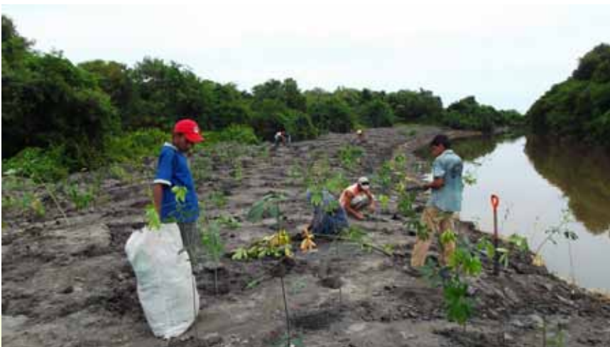
Construcción de chinampa
